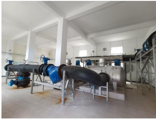
图2.3-8 2#泵站水泵
