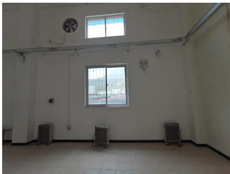
图2.3-13 泵站内部通风及采暖设施
