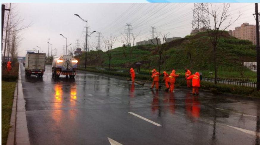
最后路面洒水冲洗和人工清扫，还原路面本色
