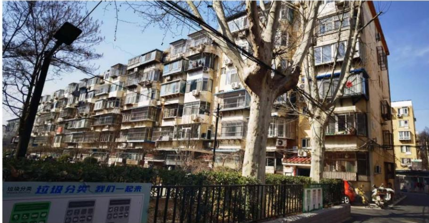
图 1-1 建筑南立面照片
