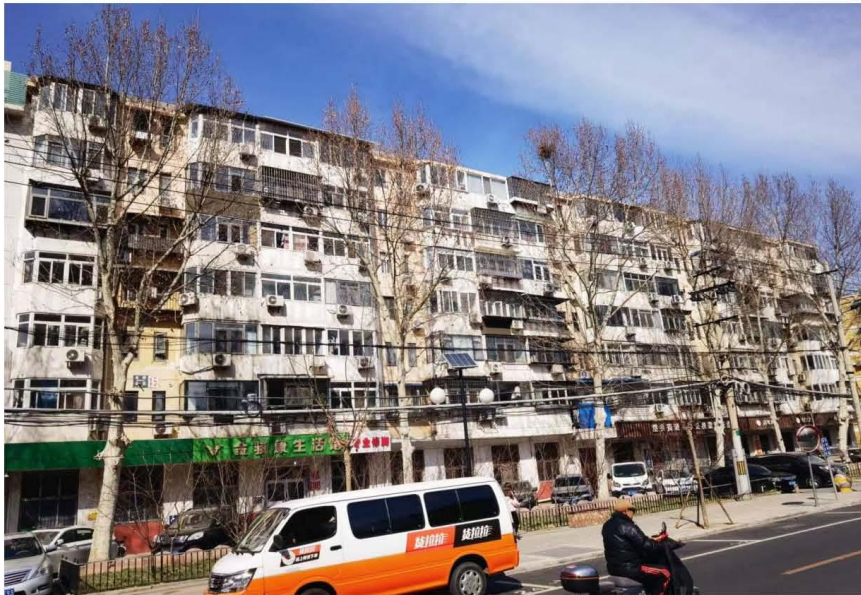
图 1-1 建筑南立面照片
