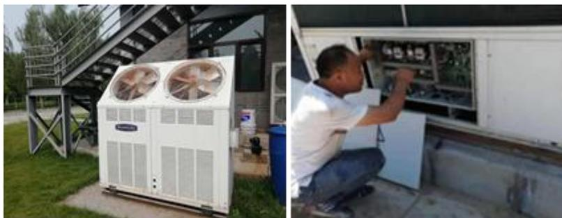
(2) 空调机清理养护-柜机、挂机：拆除及安装、清理养护，其中柜机 9 台，挂机 13 台
