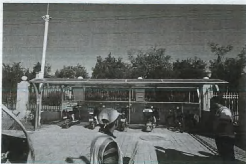
拆除现状车棚
