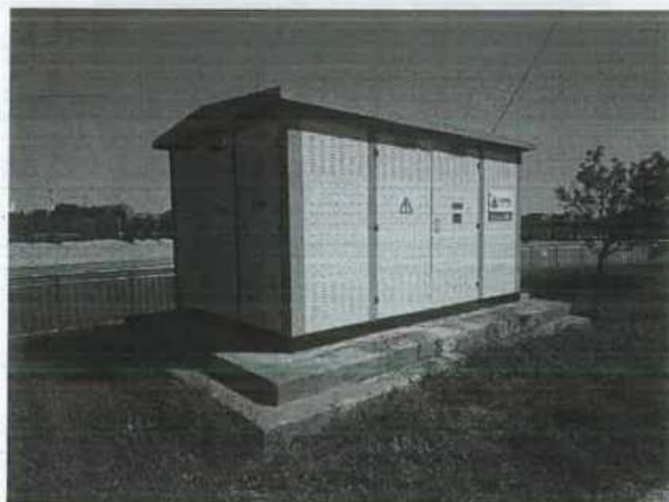
变压器室现状图
