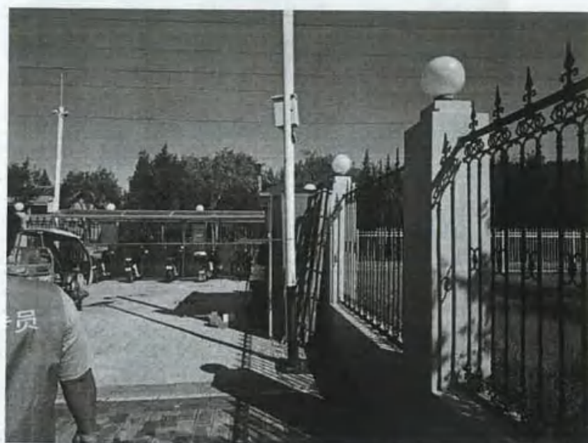
路灯及庭院灯拆除
