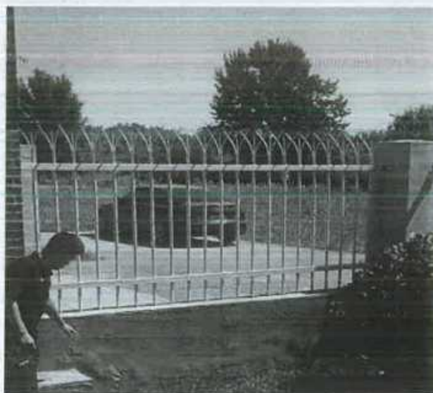
现状栏杆及墙垛拆除
