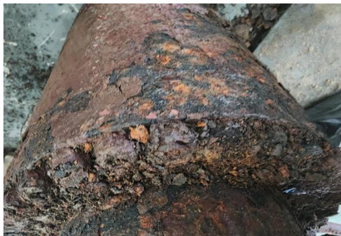
图 3 液压缸外观及各紧固件锈蚀严重
