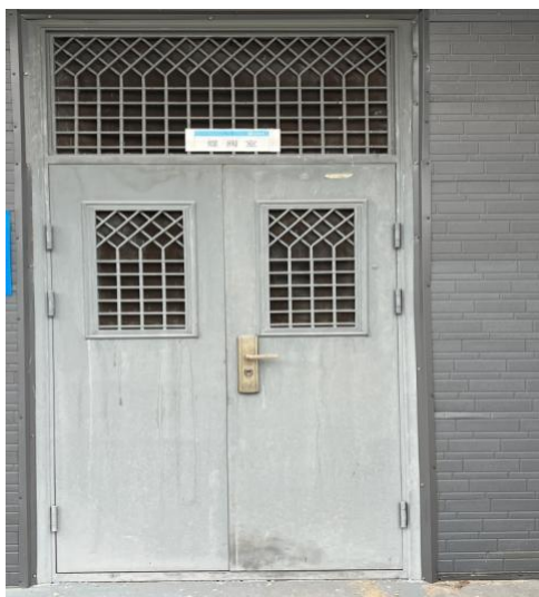
图 10.1 分水口门现状
