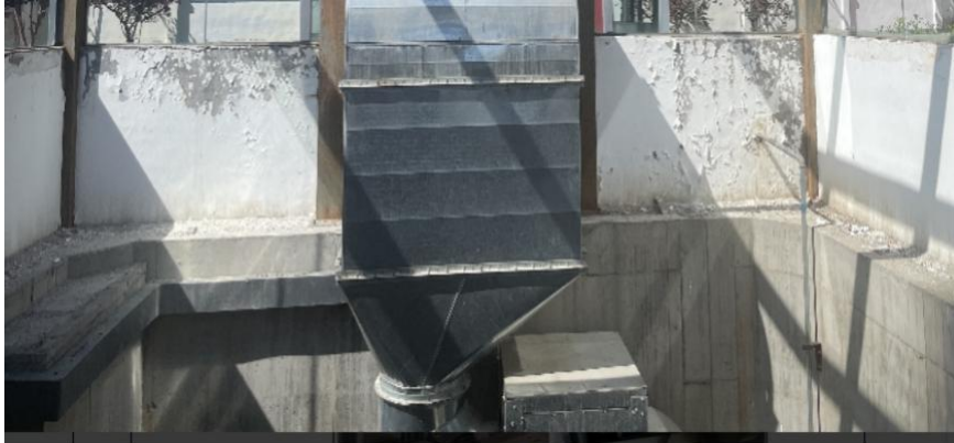
图 8.1 蝶阀室内墙现状
