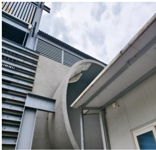
图 5.1 调压塔外墙及钢结构现状
