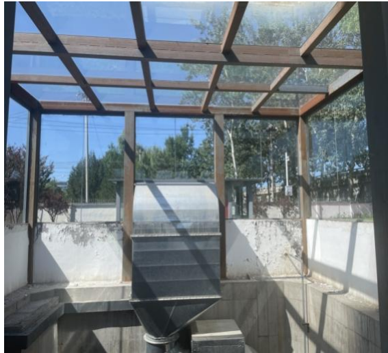
图 5.2 水源三厂蝶阀室钢结构现状
