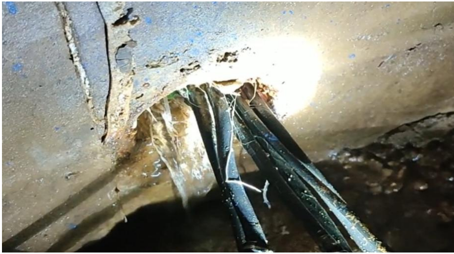
图 3.1 阀井内部现状
