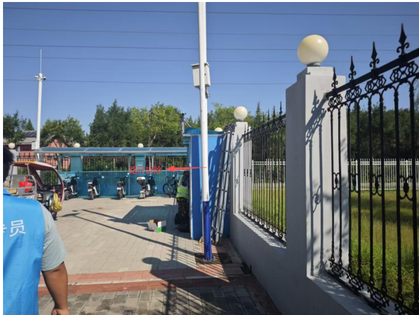
路灯及庭院灯拆除
