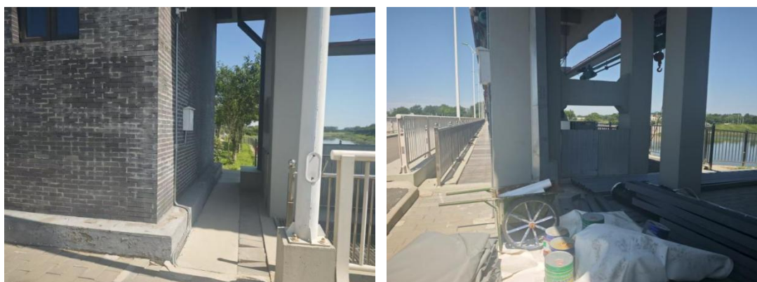
现状桥两头栏杆
