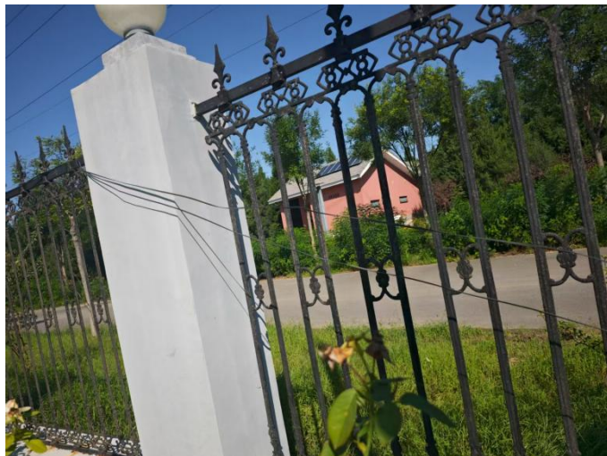
现状架空网线
