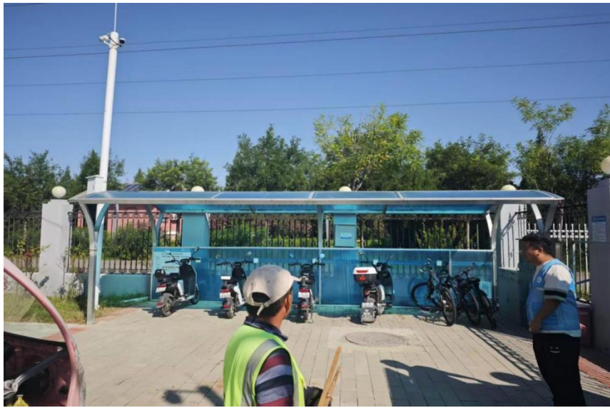
拆除现状车棚
