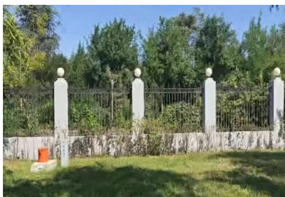
现状围墙拆除
