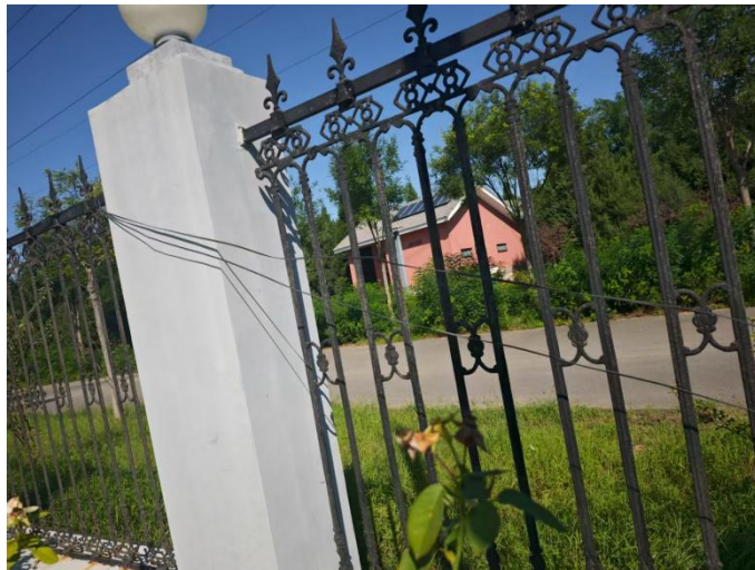
现状架空网线
