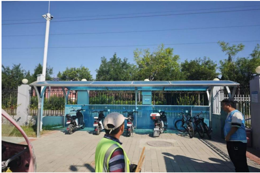
拆除现状车棚
