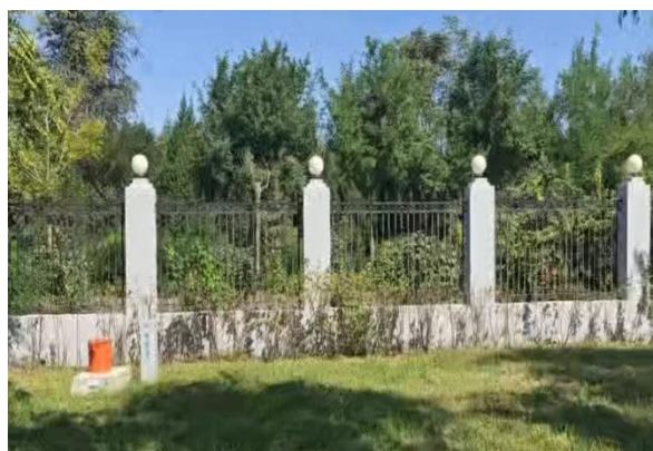
现状围墙拆除
