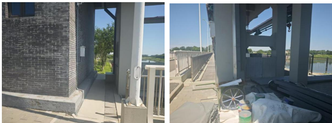
现状桥两头栏杆
