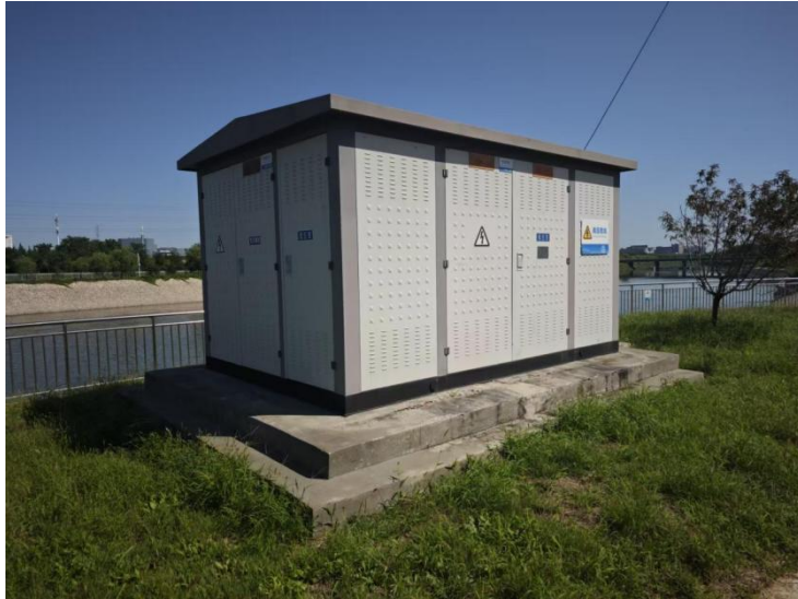
变压器室现状图
