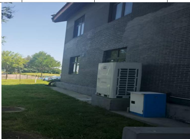
现状办公楼背面窗户
