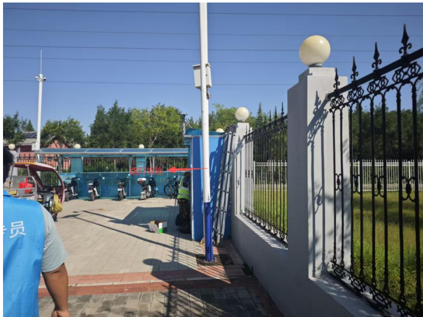
路灯及庭院灯拆除
