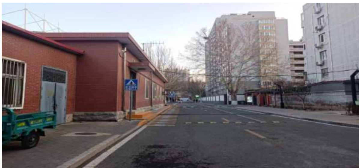
校园内中心配电室西侧位置停放发电车组
