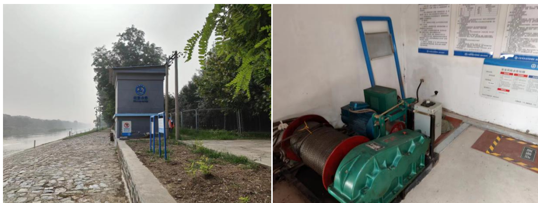
图 2-2 右岸启闭机房及启闭机
