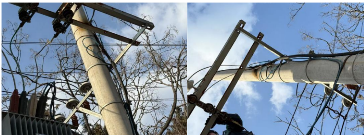
图 6 柱上变压器
