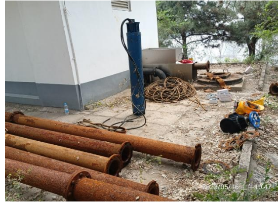
图 4.2-4 更换井用潜水电缆
