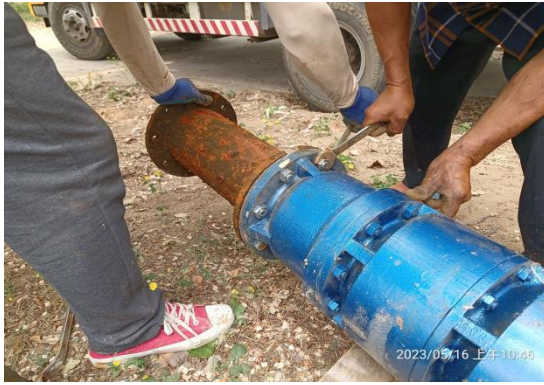
图 4.2-3 更换井用潜水泵
