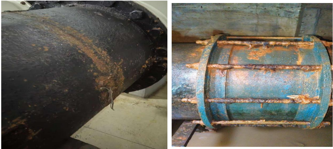
4.2-6 井内管道现状
