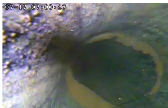
图 4.2-2 井结构损坏
