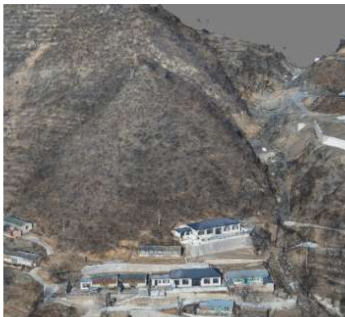
图 4.1-1 滑坡灾害隐患点航空摄影/三维模型/三维激光扫描图
