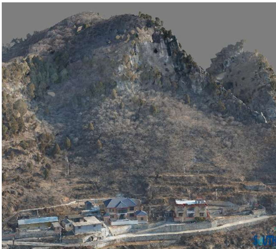
图 2.3.2-1 崩塌灾害隐患点航空摄影/三维模型/三维激光扫描图
