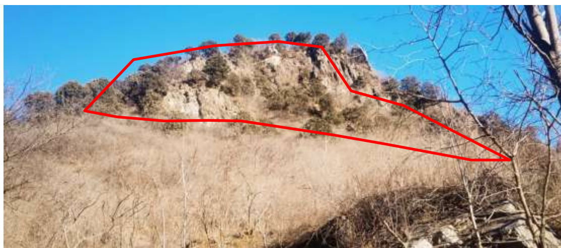
图 2.3.2-2 危岩带及崩塌体范围形态
