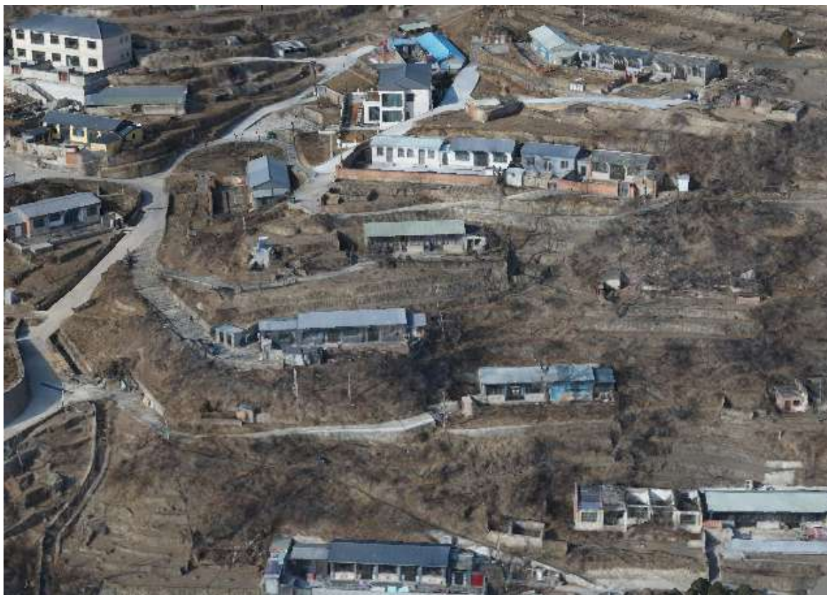
图 2.3.3-1 滑坡灾害隐患点航空摄影/三维模型/三维激光扫描图
