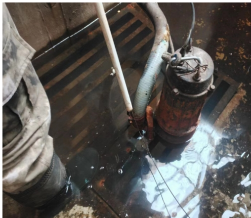
图 2.1 井室水泵现状
