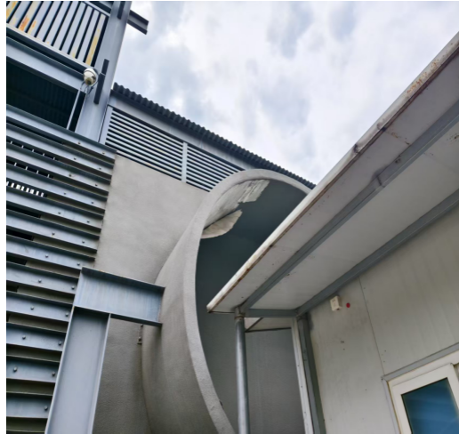
图 5.1 调压塔外墙及钢结构现状
