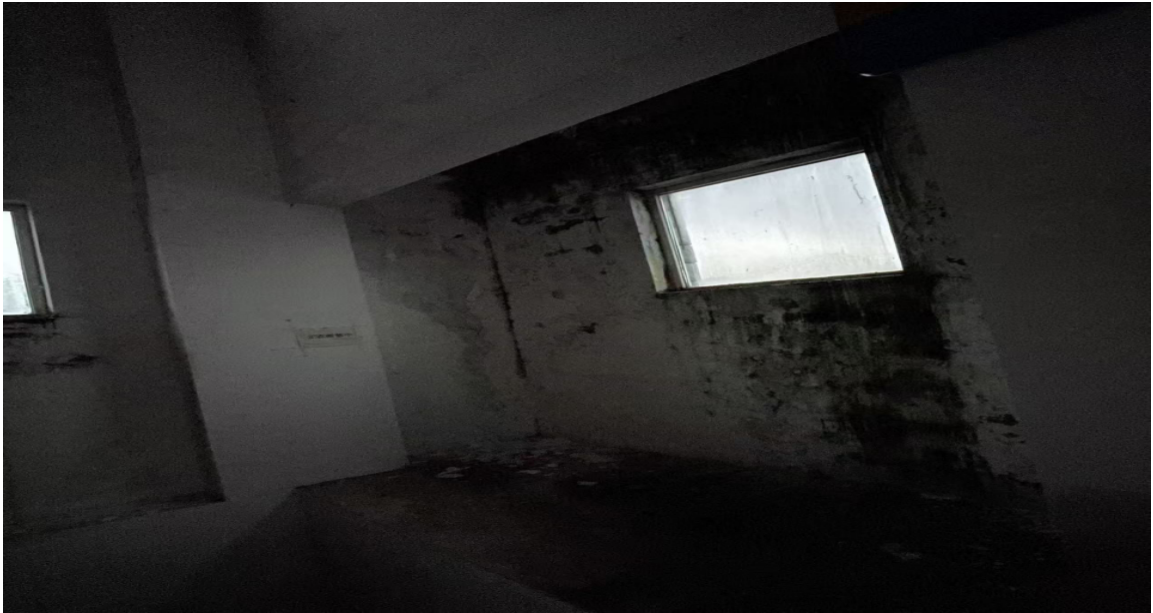
闸站内部现状
