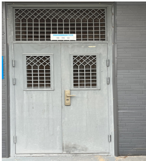
图 10.1 分水口门现状
