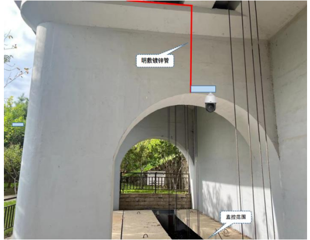
设备安装位置及配线、配管敷设示意图
