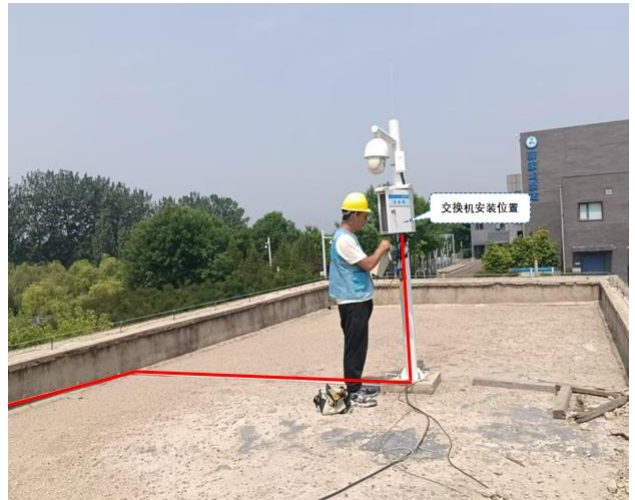
设备安装位置及配线、配管敷设示意图
