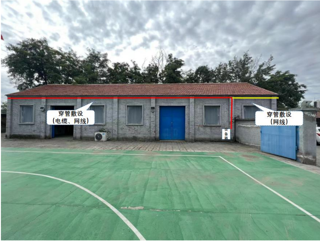
南侧仓库电缆、网线敷设示意图
