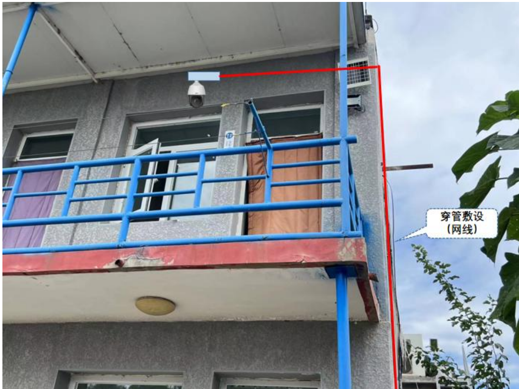
仓库管理楼 2 层电缆、网线敷设示意图
