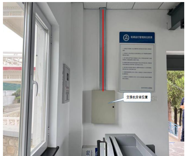
设备安装位置及配线、配管敷设示意图
