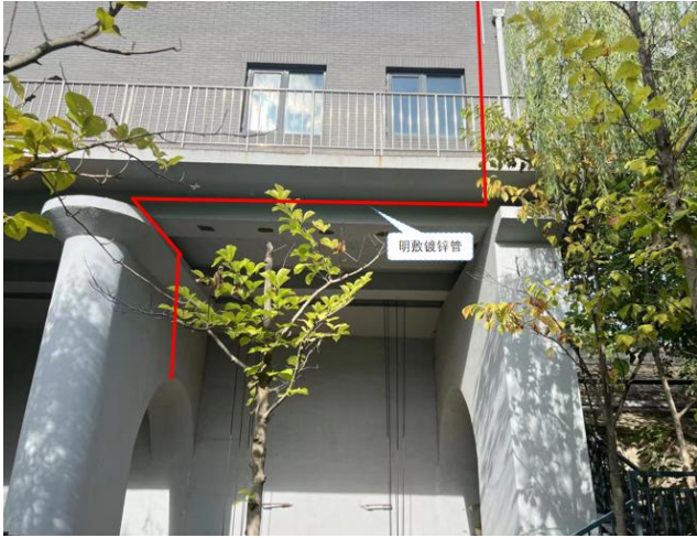
设备安装位置及配线、配管敷设示意图
