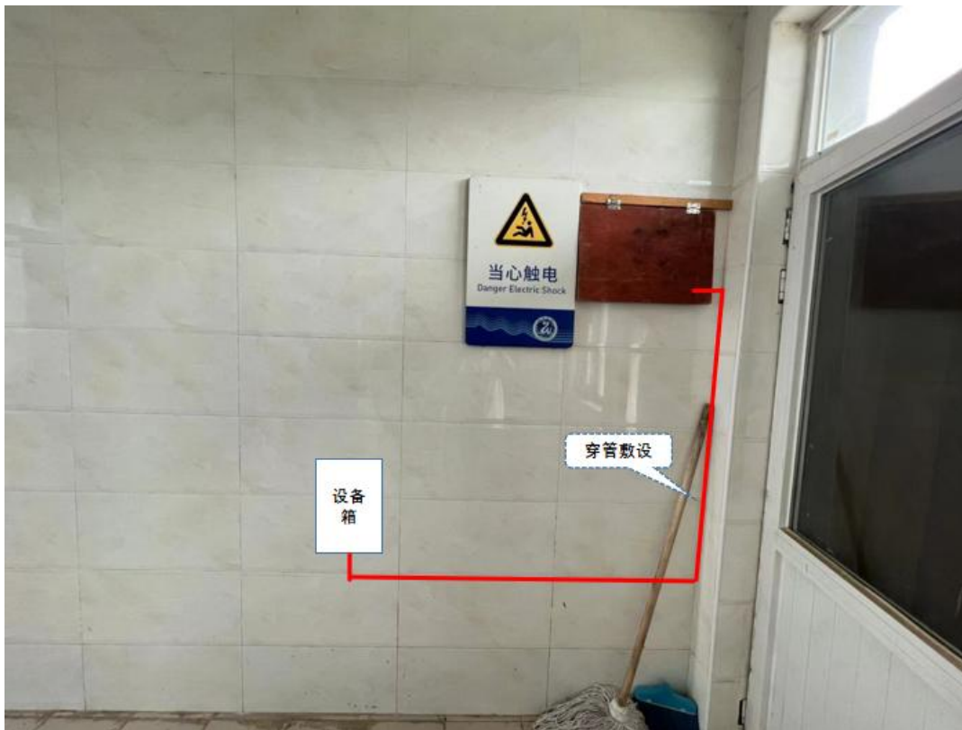
仓库管理楼 2 层卫生间取电位置及电缆敷设示意图
