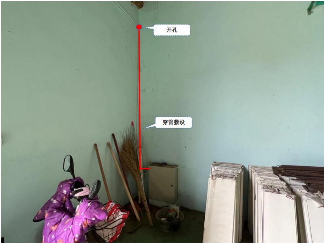
南侧仓库取电位置及电缆敷设示意图
