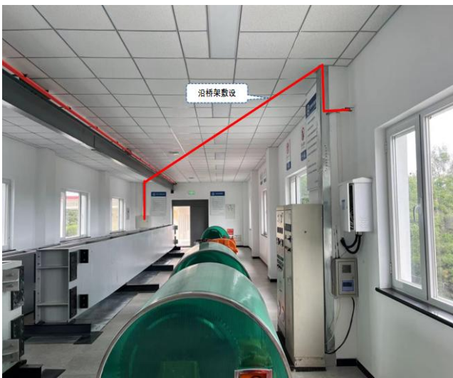
设备安装位置及配线、配管敷设示意图
