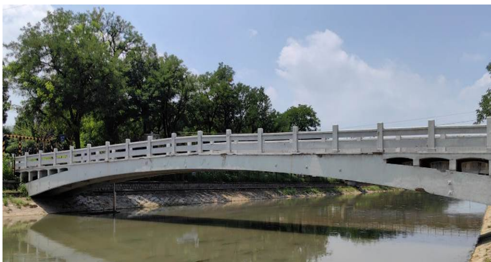
图 2-3 玉积庵桥立面照片
