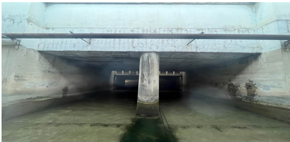
图 2-2 行集寺桥立面照片
