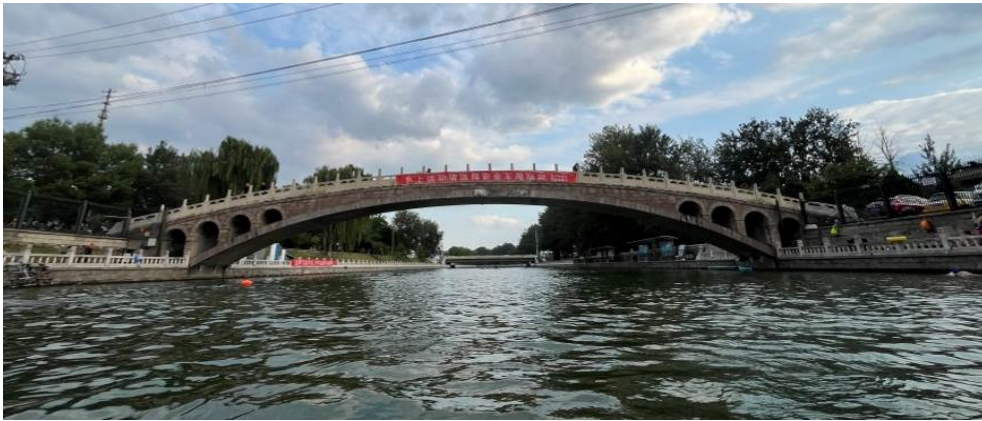
图 2-4 绣漪桥立面照片
