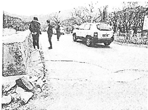
图 3.2 局部裂缝图
