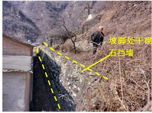
图 4-2 坡脚处较稳定干砌石挡墙
