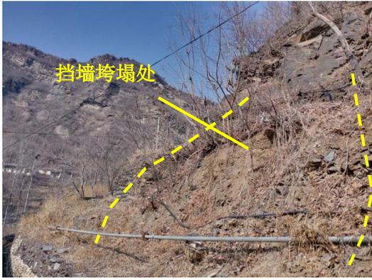
图 4-1 斜坡上破损的干砌石挡墙
