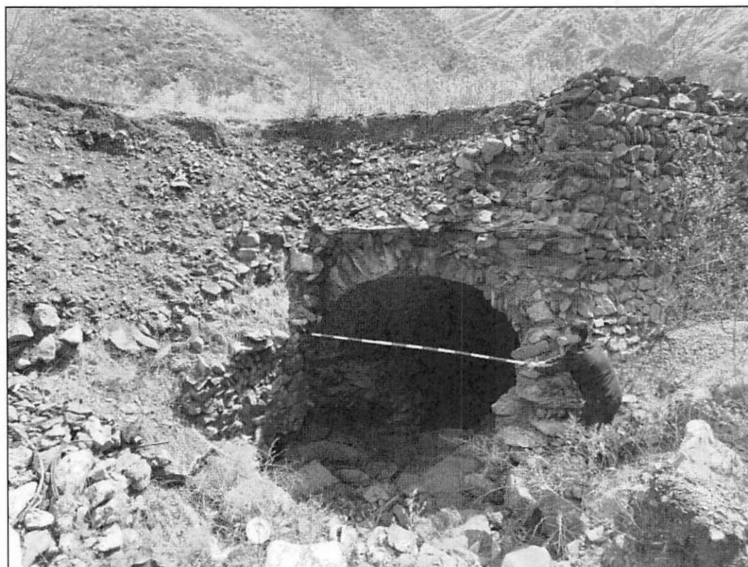
渣堆平台下过水涵洞
