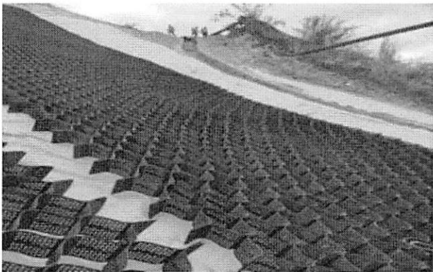
照片 3-4 植生格室施工
