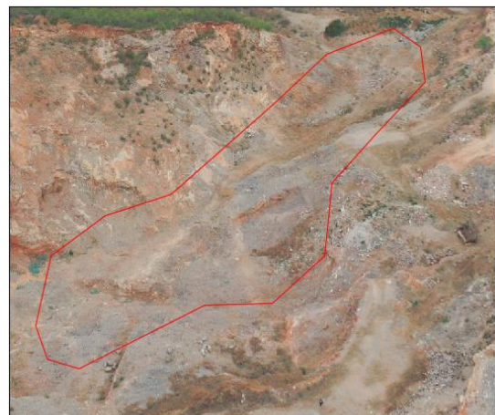
照片 3-6 PT06 全貌
