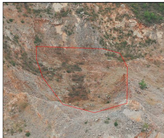
照片 3-4 PT04 全貌
