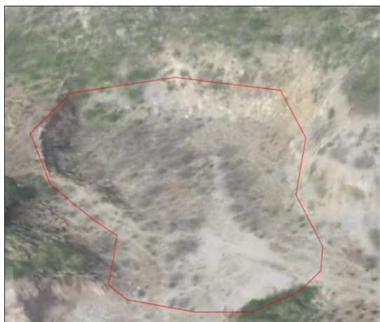
照片 3-7 PT07 全貌
