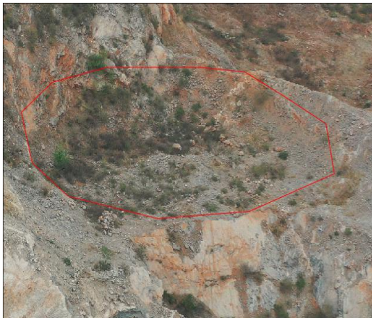
照片 3-3 PT03 全貌
