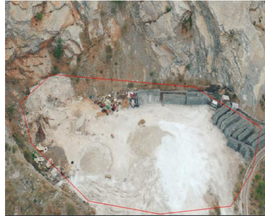
照片 3-2 PT02 全貌
