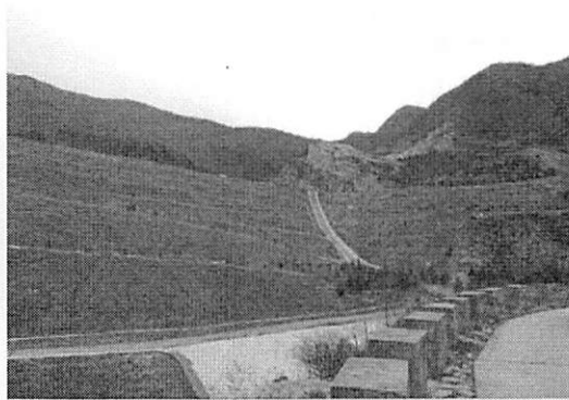
照片22 水口峪沟治理区
