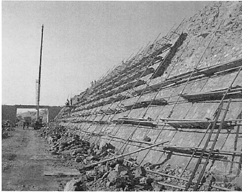
照片6.2 脚手架工程安装示意图
